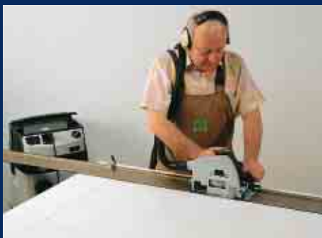
3. Einsetzschneiden mit Tauchkreissäge und Führungsschiene mit Anschlagnocken (als Rückschlagsicherung)
